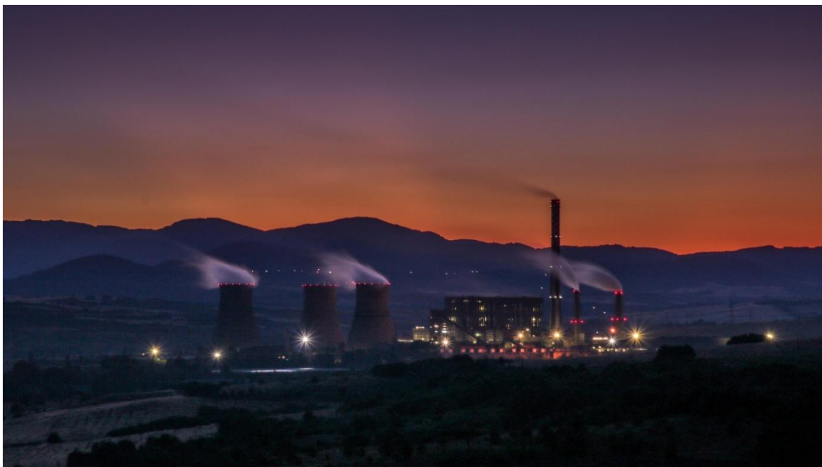
Fig 4: Thermal Power Plant, GolemoSelo, Bulgaria
